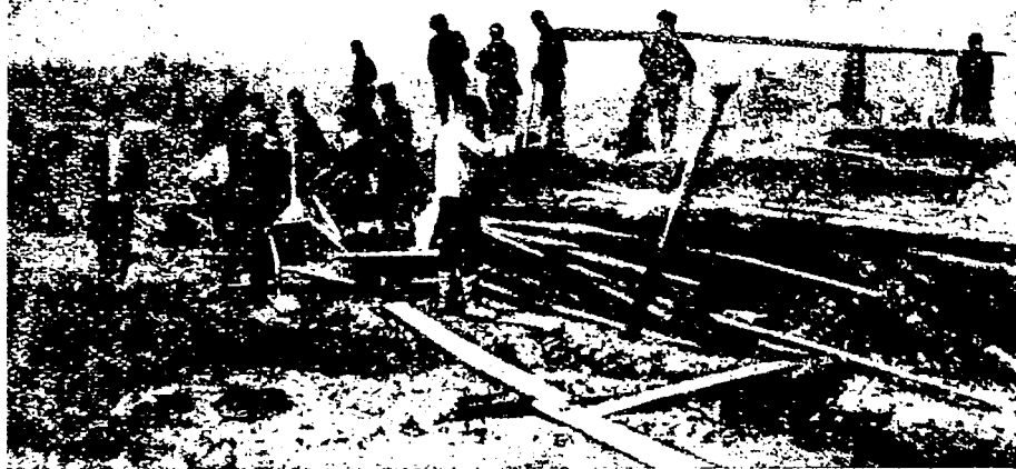
Фиг. 153. Работа с пожогом.
