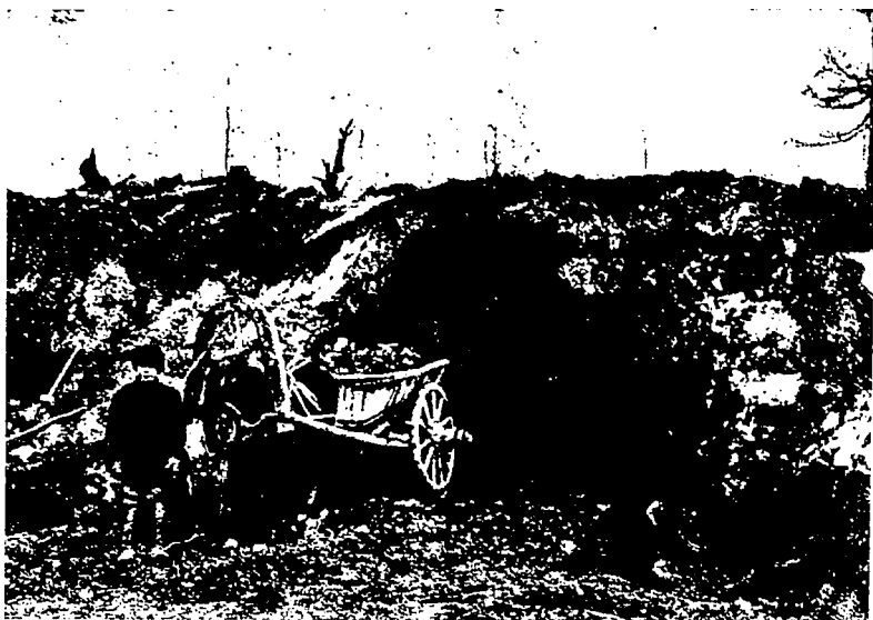
Фиг. 149. Свод из мерзлого грунта.
