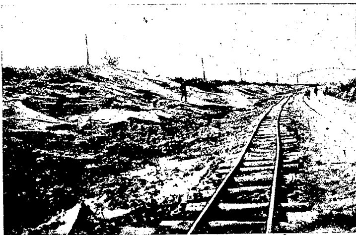
Фиг. 159. Грязная выемка с оплывающими откосами.
