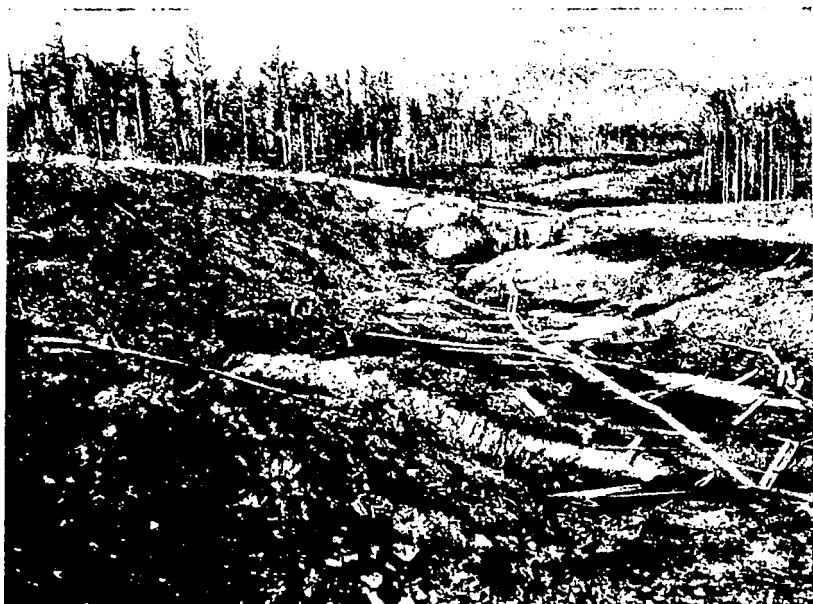
Фиг. 63. Заплывание выемки грунтом вследствие протавания линз погребенных льдов (фото В. В. Еленевского).
