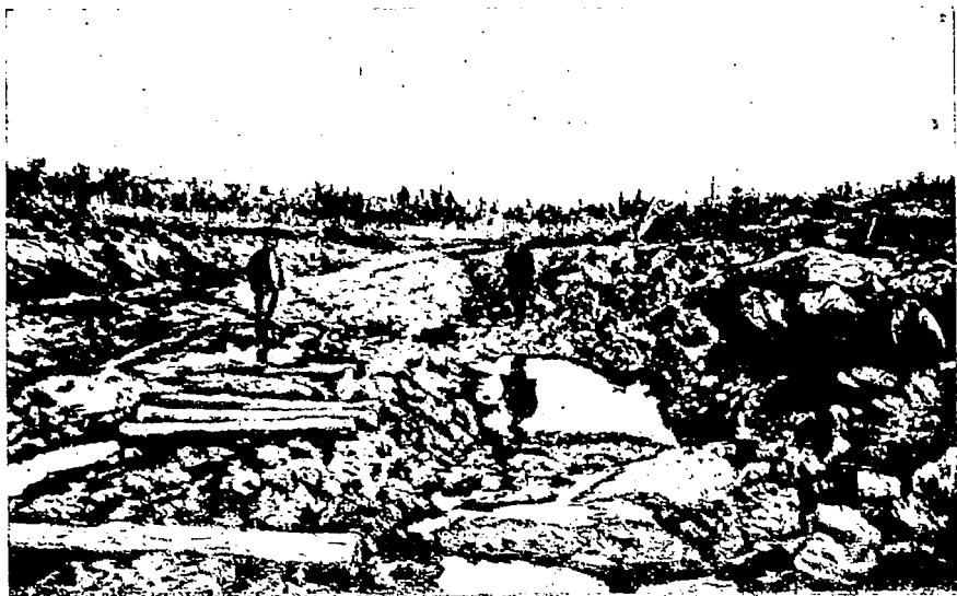
Фиг. 151. Скопление воды в грязной заплывающей грунтом выемке.
