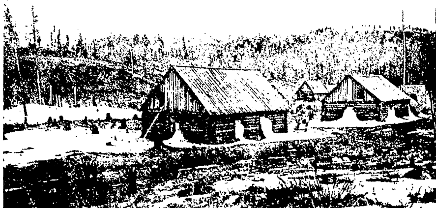
Фиг. 50. Наледь, заполнившая деревянные дома.
