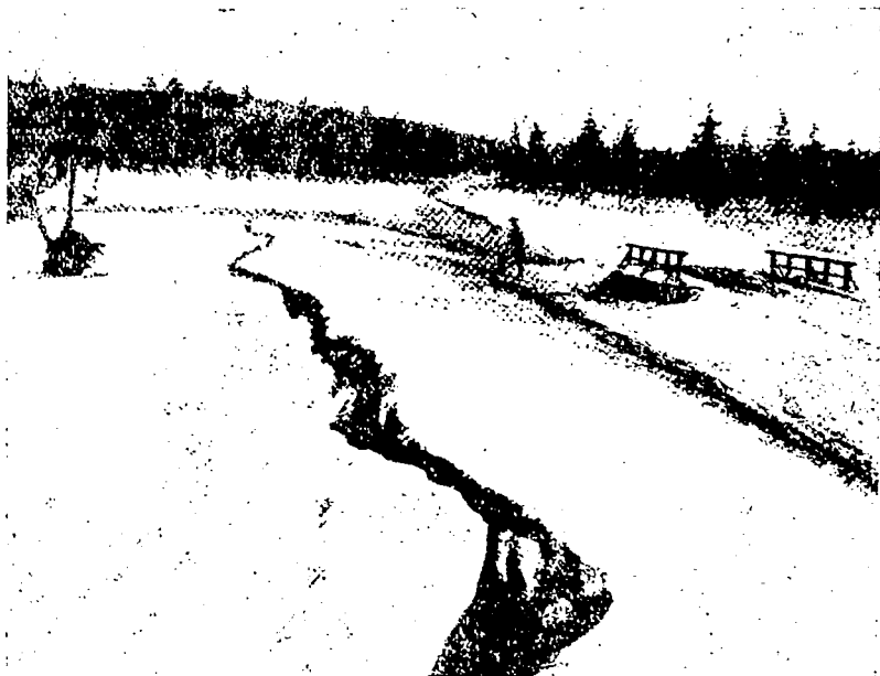
Фиг. 54. Наледь, заливающая мост на обыкновенной дороге.
