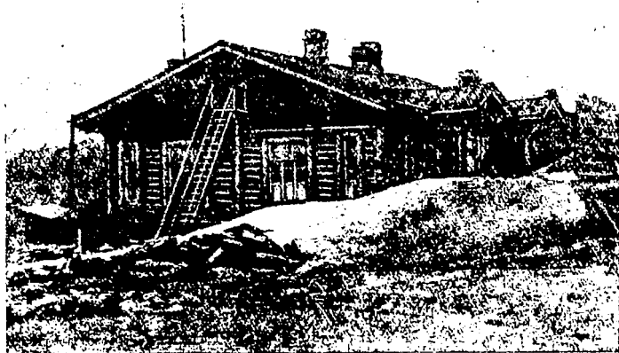
Фиг. 49. Наледь около здания.
