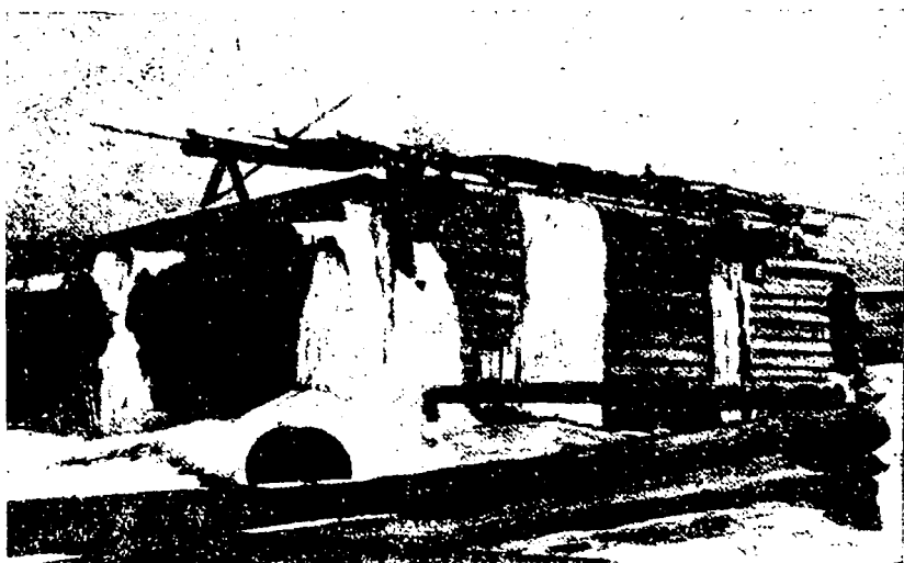
Фиг. 51. Дом, разрушенный наледью.
