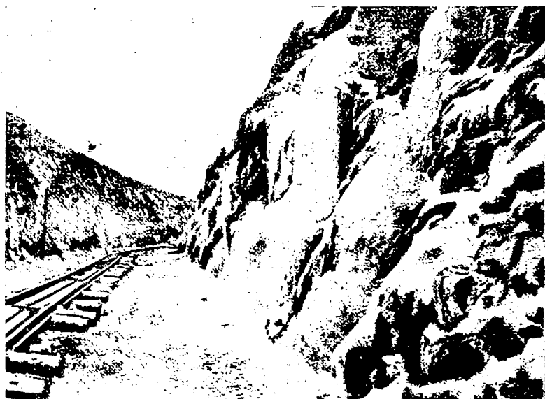
Фиг. 13. Ледопад в железнодорожной выемке.
